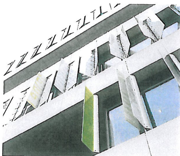
Glaslamellerne er monteret parvis på kraftige aluminiumsprofiler, der sikrer stabilitet og bevægelse i blæsevejr.
